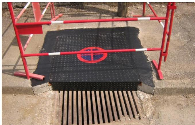
Rue du ruisseau, la trappe de visite de la canalisation du Weihergraben, vétuste et dangereuse a été sécurisée. L'ouvrage consolidé et restructuré sera protégé par deux potelets.
