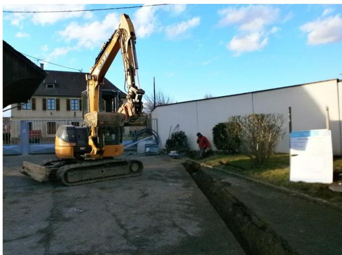
Des travaux d'adduction en eau potable et branchements au réseau d'assainissement ont été effectués au courant du mois de janvier.
