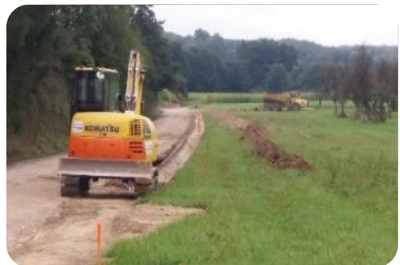
Préparation du chemin pour l'enrobé
