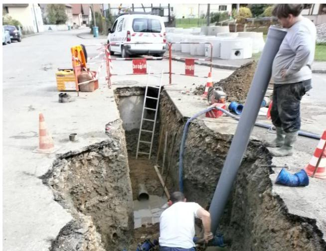
Le passage sous la canalisation de l'ancien ruisseau, une opération redoutée qui finalement s'est déroulée sans difficulté majeure. Profitant de ces travaux la municipalité a également mis en place des regards extérieurs de comptage pour l'eau potable, et réalisé le renouvellement des branchements de particuliers les plus anciens. Elle remercie les riverains pour leur patience et leur compréhension suite aux désagréments causés par ces travaux.
