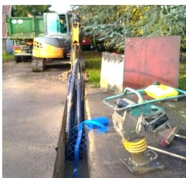
Le réseau d'eau potable desservant les riverains de la rue de l'étang vient d'être modifié et rénové. Auparavant les canalisations traversaient les terrains privés. Cette opération a permis de régulariser la situation et de mettre en place des regards de comptage extérieurs.
